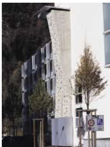
Abgedeckte Kletterwand im öffentlichen Bereich
