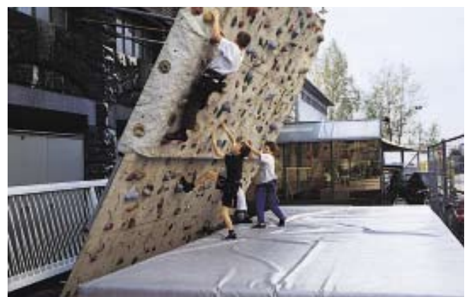
Sturzbereich mit Schaumstoffmatten abgedeckt
